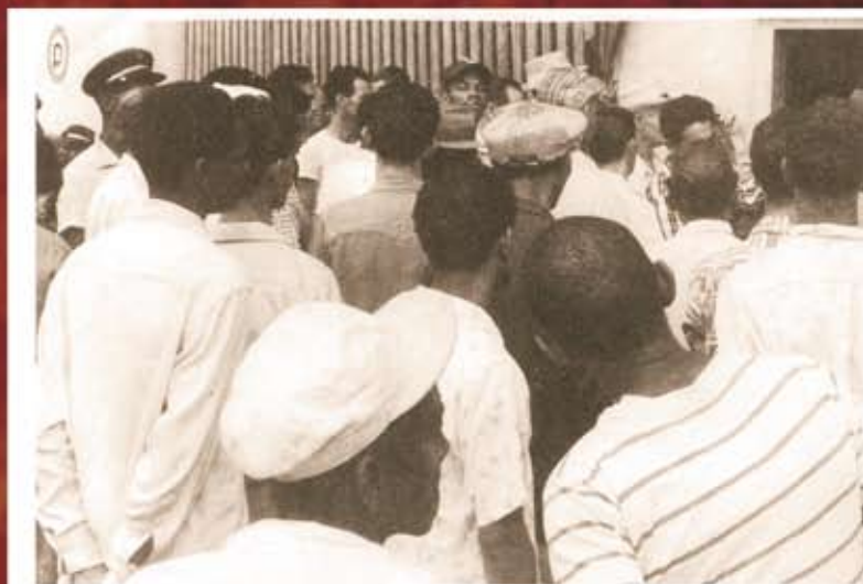
Al abrirse las obras del Túnel bajo la bahía de La Habana, la cantidad de gente que acudió allí en busca de empleo fue tal que hubo un desorden público. Aquí los aspirantes a trabajar hacen cola para llenar la planilla que les facilite obtener empleo.
